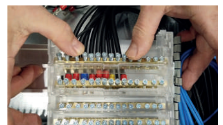
Cablaggio per singola barretta Wiring per each bar
